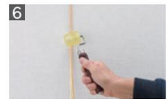
アタッチメントにジョイナーをローラーで押し込みます。ジョイナーはカッターで切れます。接合部分には接着剤の併用をおすすめします。
