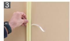
両面テープを剥がした後、下地に合った接着剤を塗布し、墨ラインに沿ってアタッチメントを取り付けます。
