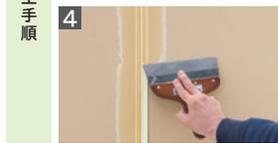
パテ処理をします。アタッチメント基部の厚みは0.6mmです。アタッチメントにはパテの付着を良くする細かい溝が付いています。
